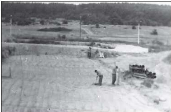
Der Erdaushub wurde am Waldrand verschüttet und daraus später ein Rodelberg angelegt.
